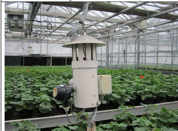
Le détecteur relié à l'ordinateur central permet la gestion automatique
